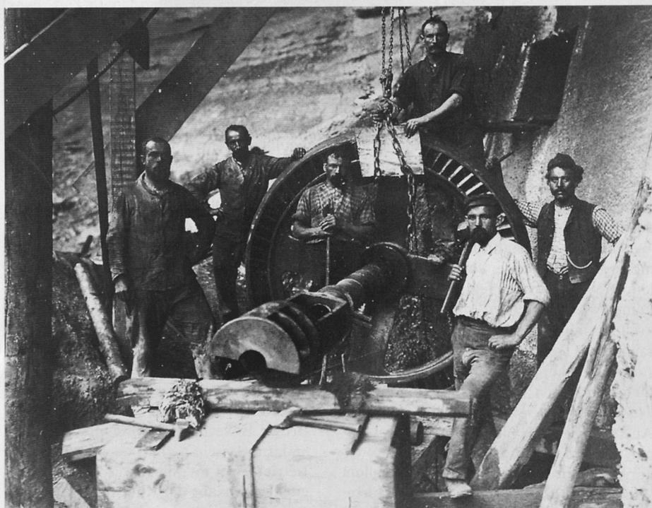
Kammradreparatur im Kraftwerk Pilgersteg um 1892, ausgeführt durch Angestellte der Firma Hess und der Herstellerfirma Egli & Huber (Trox Hesco).
